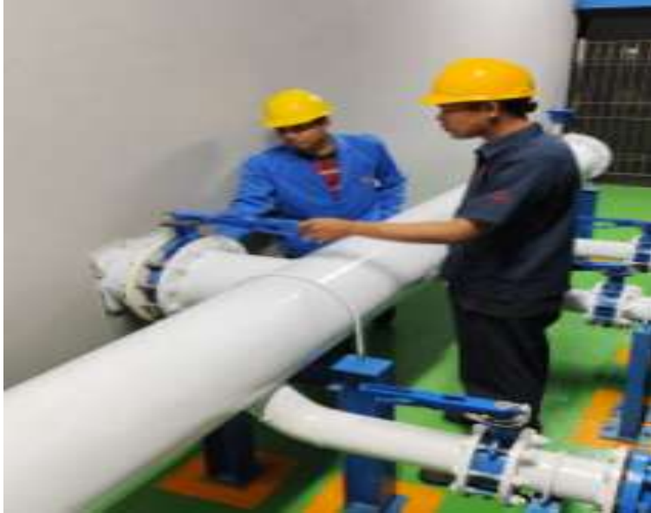
Proses pengukuran jarak sambungan pada pipa
