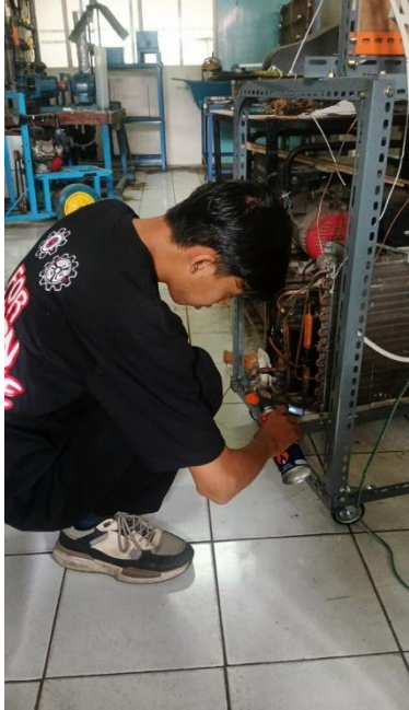
Penyambungan pipa tembaga
