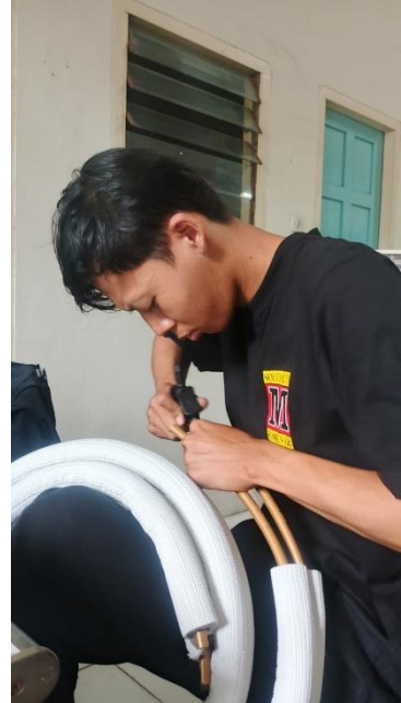
Pembesaran lubang pipa
