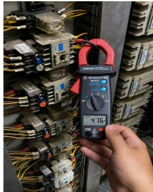
GAMBAR 10 Data pengukuran Arus 4,76 A
