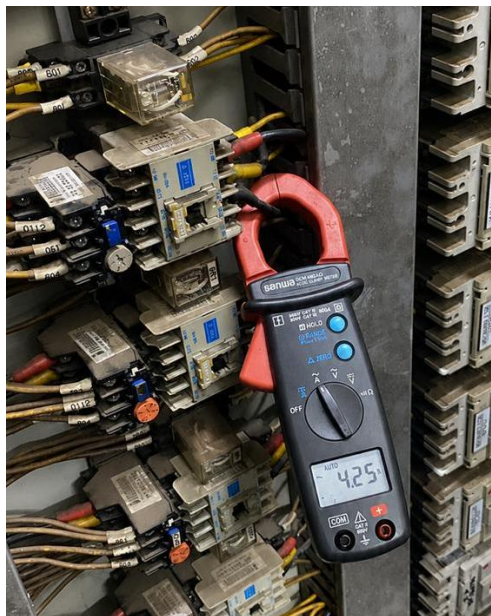
GAMBAR 9 Data pengukuran Arus 4,25 A
